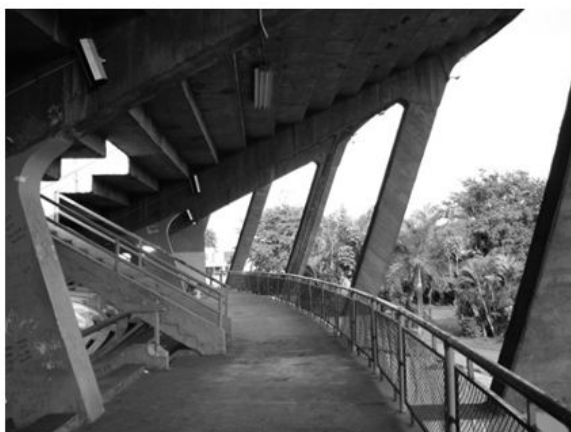
Figura 2. Estructura interna de la Tribuna Sur del Estadio Olímpico Pascual Guerrero.
