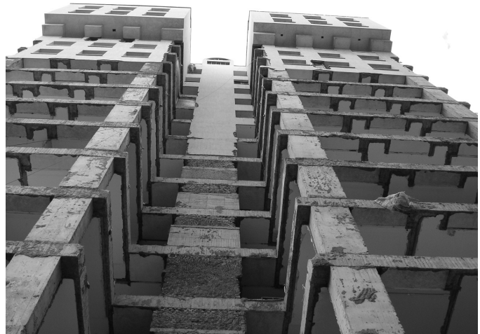
Figura 3. Imagen del edificio Torres de la Plazuela (torre A), tomada el 13 de julio de 2005.
