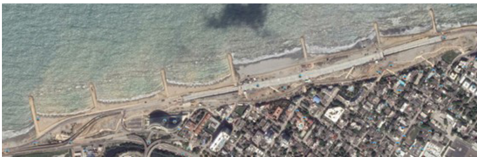
Figura 14. Imágenes satelitales de zona de obra noviembre 2015 finalización de la estructura de muro sumergido (33)
