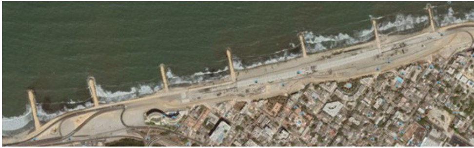
Figura 13. Imágenes satelitales de zona de obra marzo 2015 inicio de muro sumergido (33)
