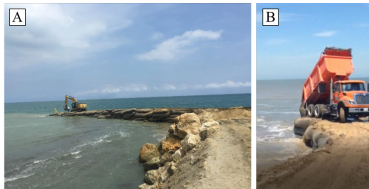
Figura 8. Proceso constructivo muro sumergido (A y B)
