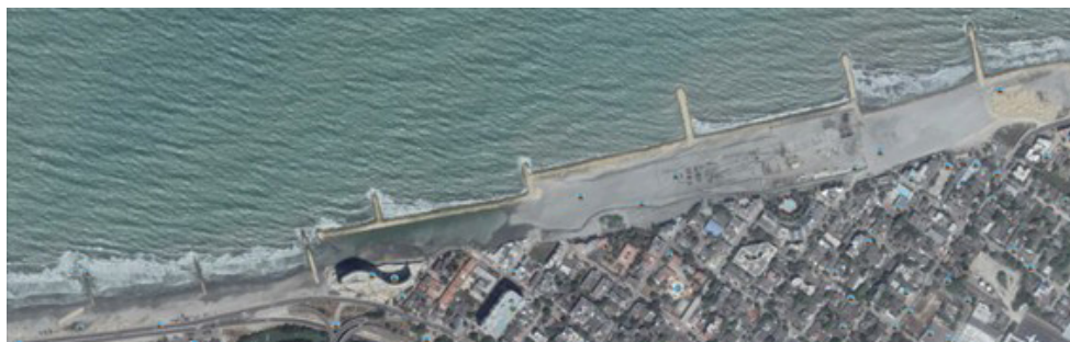
Figura 10. Imágenes satelitales de zona de obra febrero 2012 construcción de primeros 4 espolones (30)
