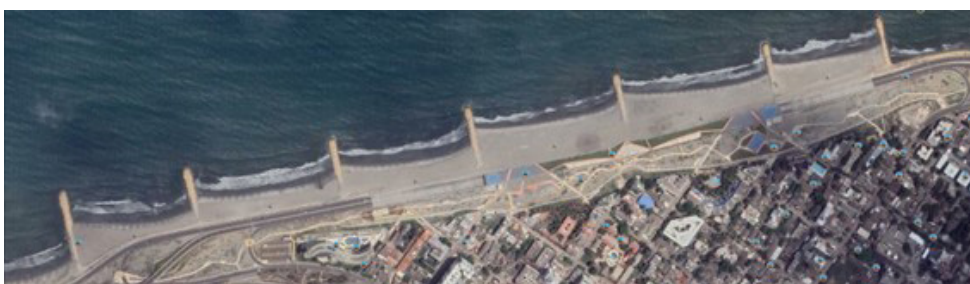
Figura 16. Imágenes satelitales de zona de obra julio 2016 (34)
