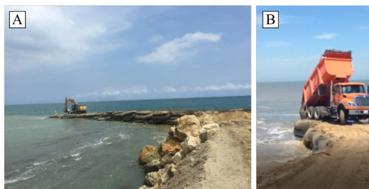
Figura 8. Proceso constructivo muro sumergido (A y B)
